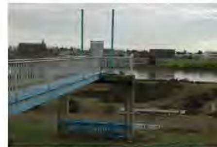
雨水などを多摩川（奥）に排出する山王排水樋管。水門は閉められず、増水した多摩川の濁流が逆流した可能性がある＝川崎市中原区
